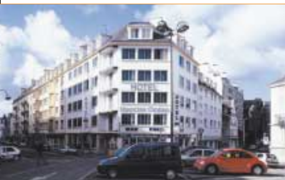
Vue actuelle de la place Lyautey, rue L.C. Maury, rue C. Pobéguin. (phot. Stéphane Le Bourhis / CAUE 56)
