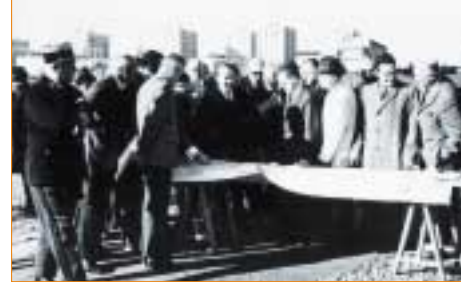
Visite de chantier à Kercado. (fonds Archives Municipales de Vannes)
