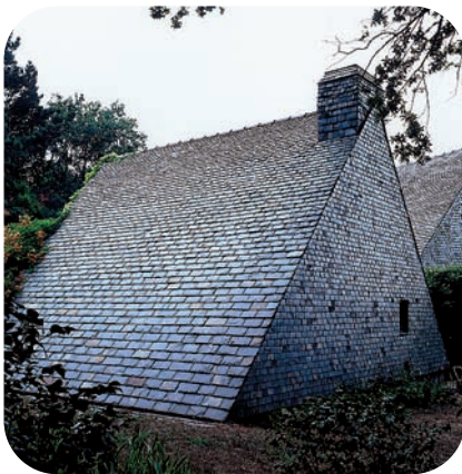
30 - Maison Bellanger de Yves Guillou à Baden
