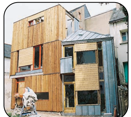
29 - Maison Chauchat à Vannes
