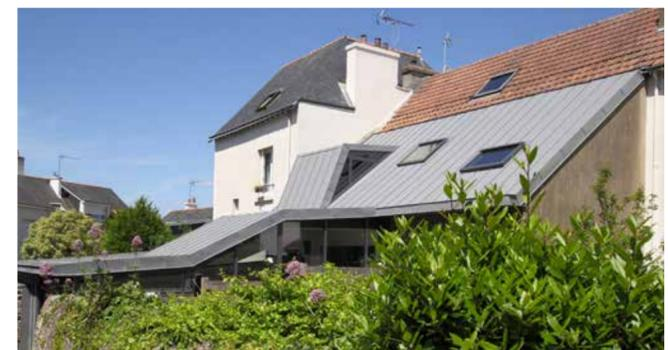
Cet origami de toiture en zinc prépatiné vient également recouvrir la première extension dont la toiture avait besoin d'être refaite. Cela a été l'occasion de donner à une des chambres sous rampant existantes un vrai volume en créant une grande lucarne dans la continuité des déploiements de toitures amorcés sur la nouvelle extension.
