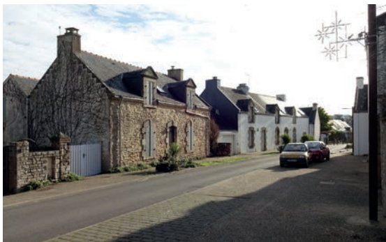
Bâtiments en R+comble alignés sur rue et appartenant à la même typologie
