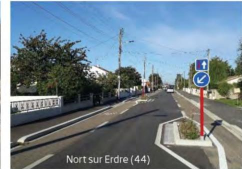
Les 2 rives (cyclables) se distinguent de la chaussée (voie auto) par l'emploi d'un matériau ou d'une couleur différente. La vitesse des véhicules est réduite grâce à une écluse.
