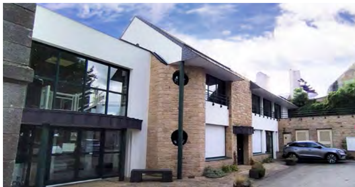
La mairie : une façade principale orientée nord-ouest caractérisée par une entrée difficilement identifiable.
