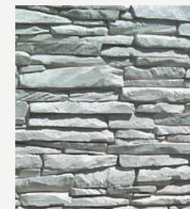
Mur à parement matricé avec effet pierres sèches
