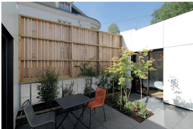
L'extension est en ossature bois et présente un bardage en red-cedar en continuité avec la clôture du jardin. Le soubassement en continuité du muret de la clôture est en béton préfabriqué laissé brut.
